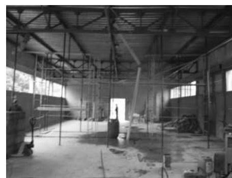
Travaux de consolidation de la toiture dans l'ancien atelier
