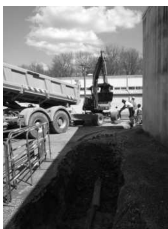
Déplacement de la ligne haute tension
